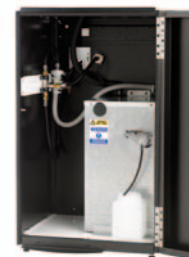
Køleanlæg i underskab
